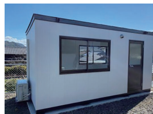
エアコンハウス
